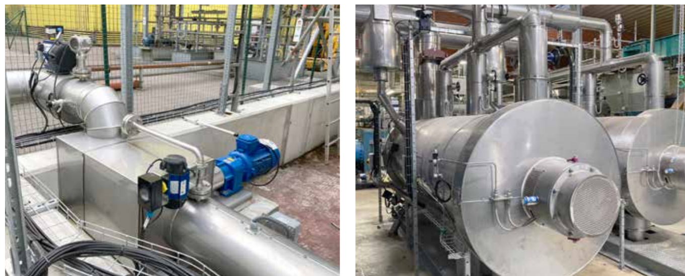
Bild oben: Das Fundament und die Aufmauerung des Tanklagers wurde von Power Oil erstellt, während die Tanks, Stützen und Rohrleitungen von GIG Karasek errichtet wurden. Bild links: Probenentnahmestelle. Bild rechts: Die blaue Schmiermittelpatrone zur Schmierung der Lager ist einfach auszutauschen und muss nur zweimal pro Jahr gewechselt werden. © GIG Karasek
