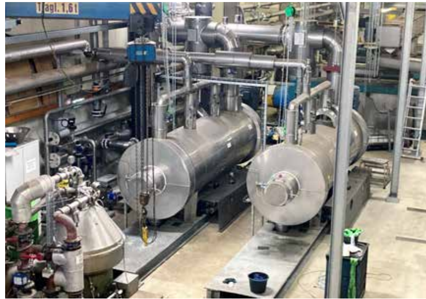
Errichtung der Trockner auf engstem Raum. © GIG Karasek
